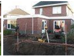
Bezig met de werkzaamheden
